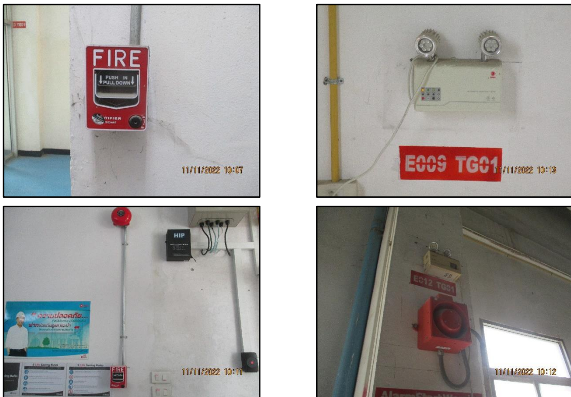
ภาพที่ 2.16 ระบบตรวจสอบตรวจจับ และสัญญาณเตือนภัยแบบอัตโนมัติภายในโครงการ
