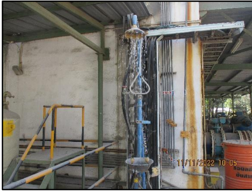
ภาพที่ 2.17 ฝักบัวฉุกเฉินและอ่างล้างตาฉุกเฉินภายในพื้นที่โครงการ
